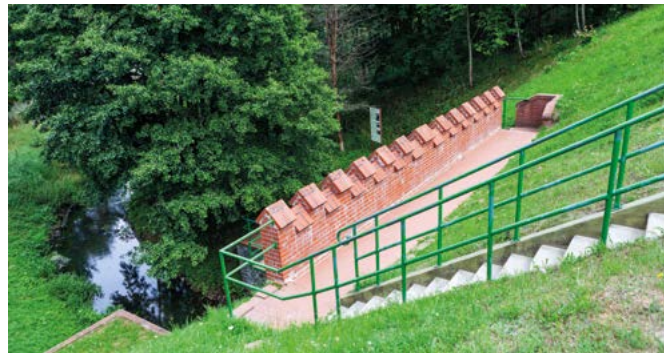
Akwedukt w Fojutowie
